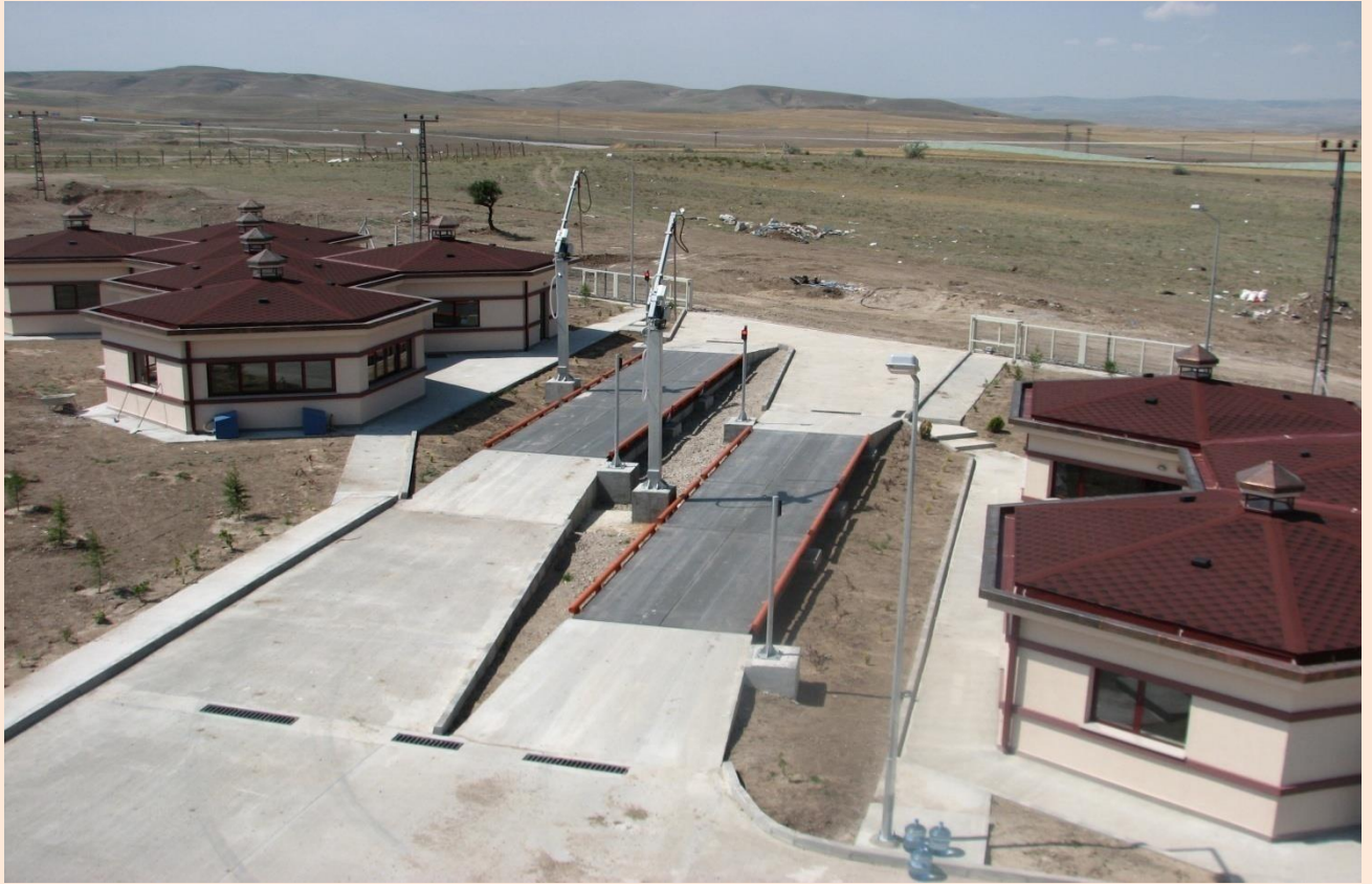
30.000 TON KAPASİTELİ ÇELİK SİLO TESİSLERİ 60 TONLUK TAŞIT KANTARLARI, OTOMATİK NUMUNE ALMA CİHAZLARI, FİZİKSEL VE KİMYASAL LABORATUVARLAR, İDARİ VE SOSYAL BİNALARIN GÖRÜNÜŞÜ
